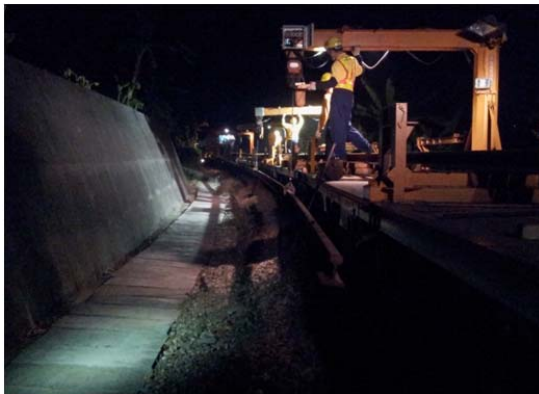
圖 3-42 抽換鋼軌作業現況
