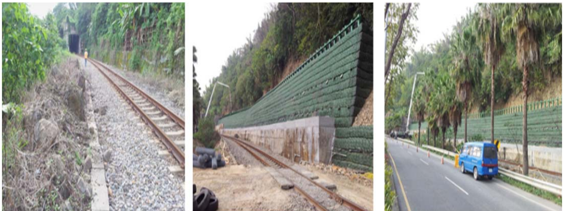
圖 3-30 集集支線 K25+560 邊坡落石整治實績
