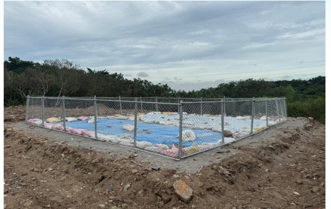
臺中市大肚掩埋場完成圍籬設置及表面覆蓋
