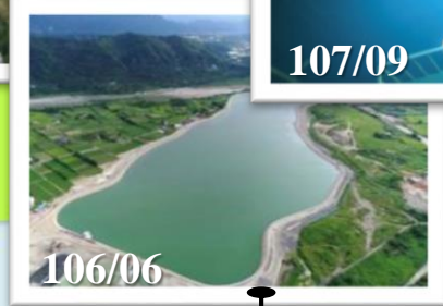
中庄調整池 (已供水)
