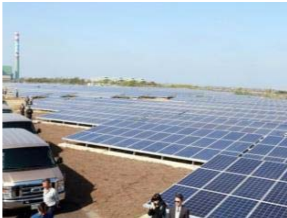
台南城西 (1.5 MW) 垃圾掩埋場
