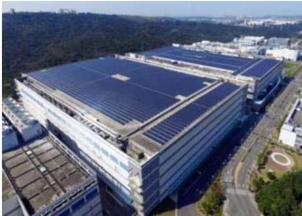
友達光電龍科廠 (9.868 MW) 最大屋頂型
