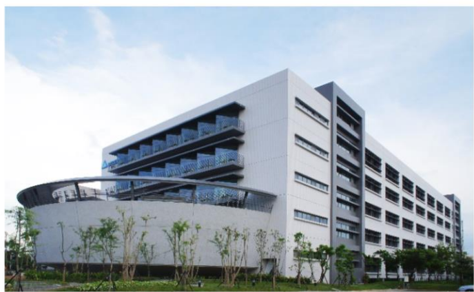
台達電子 南科廠二期廠房
