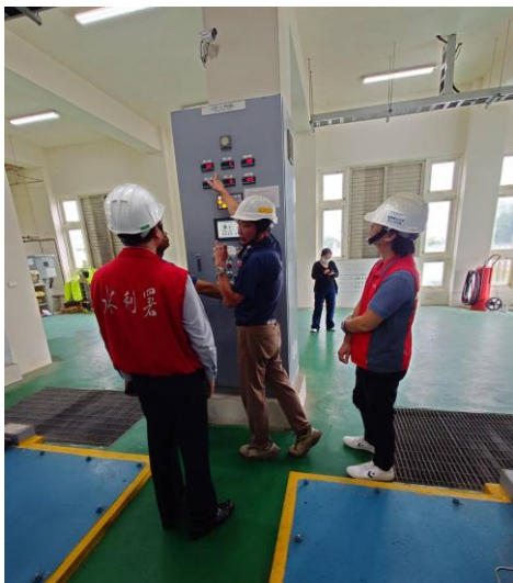
新竹南寮抽水站
