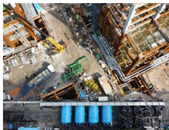
建築工地地下水利用 (快濾桶及管線)
