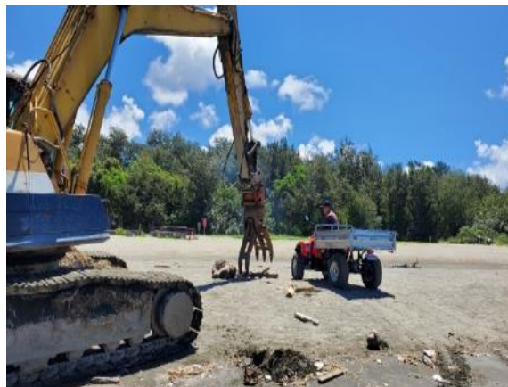
沙灘區域 挖土機具清理
