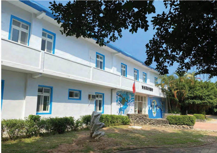
說明：原臺灣省保安司令部職業訓導第三總隊原址現況，原建物已拆除，現為海巡署「屏東琉球海洋驛站」。(促轉會攝)
