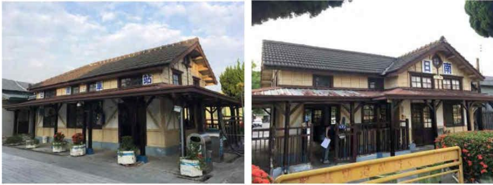
日南車站現況照片
