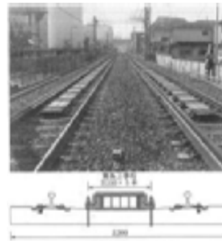
鋼軌吊梁保護工
