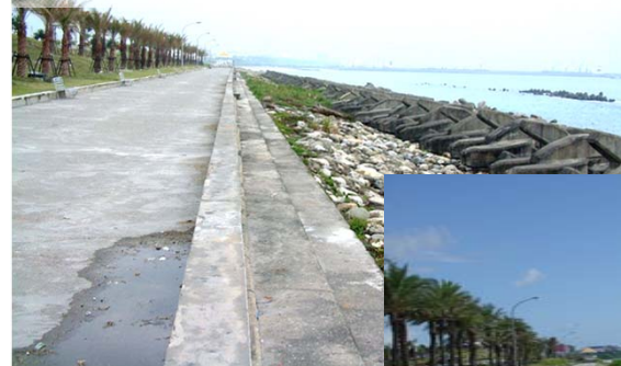
花蓮南濱海堤改善前
