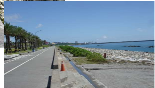
花蓮南濱海堤改善後
