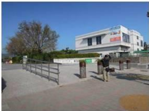
臺北市新生公園 說明：高低差設置斜坡及扶手
