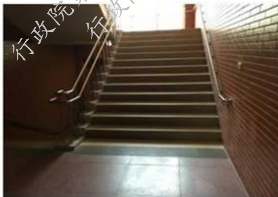
桃園市休閒文教空間無障礙樓梯 說明：防護緣、樓梯扶手高度水平延伸警示設施符合引導標誌等均符合建築物無障礙設施設計規範。
