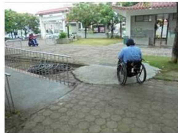
嘉義縣新港鄉公園 說明：增設斜坡提供輪椅通行
