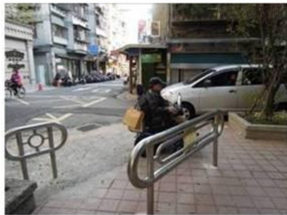
臺北市八德公園 說明：路阻保留輪椅直線通行
