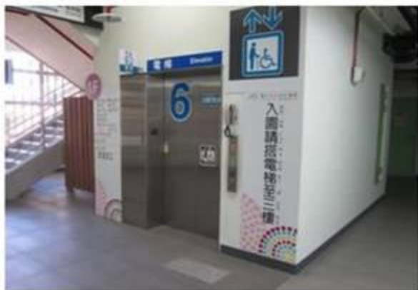
臺北市休閒文教場所昇降設備 說明：明顯設置無障礙標示，並提點字設施與入口觸覺裝置，均符合建築物無障礙設施設計規範。
