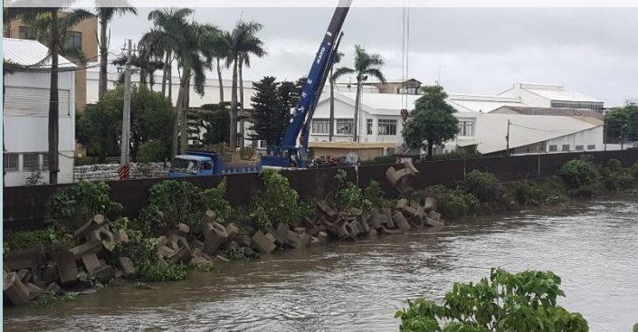
水利署第六河川局於8月27日吊放 20個5噸防汛塊完成50公尺保護。
