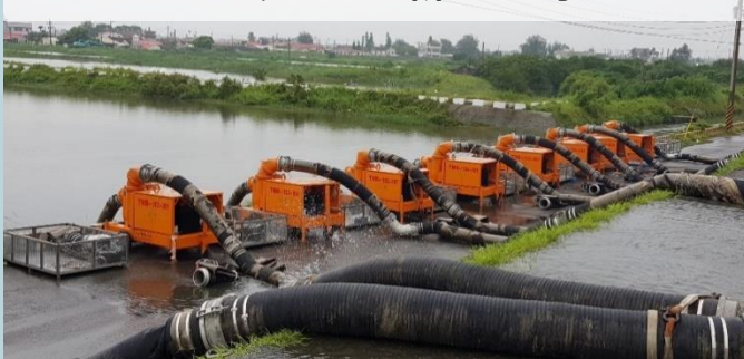
台南市北門區新園抽水站
