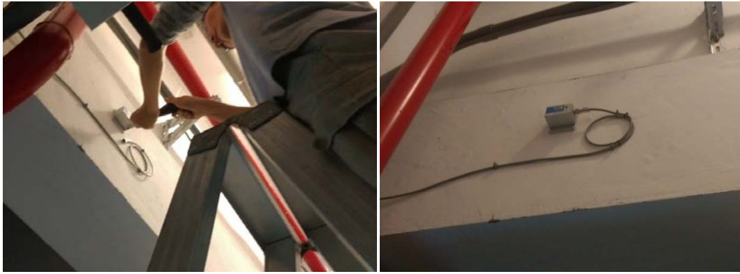
圖 67 現地型地震速報主站結構體備援地震儀施工照片
