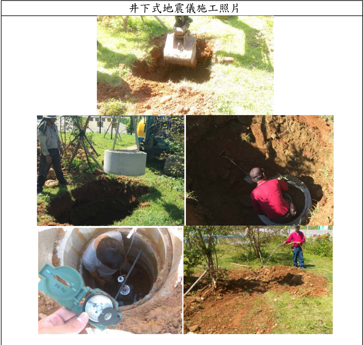
圖 66 現地型地震速報主站井下式地震儀施工照片
