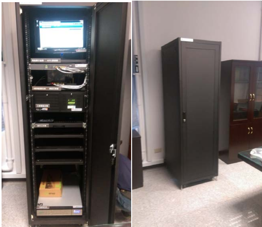
圖 68 現地型地震速報主站設備機櫃施工照片
