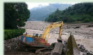
106 年 06 01 豪雨南投縣梅竹義鄉同高村陸軍部溪和社溪陸基搶險工程
