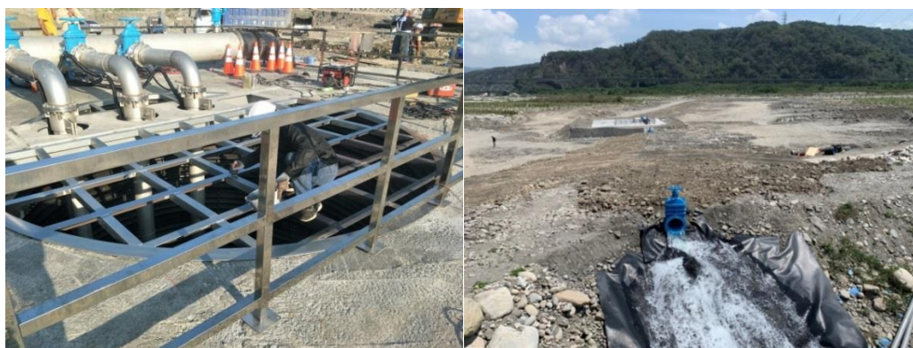
圖 3-2 大安溪緊急伏流水
