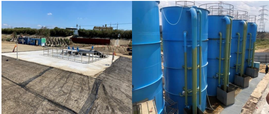
圖 3-3 烏溪緊急伏流水工程
