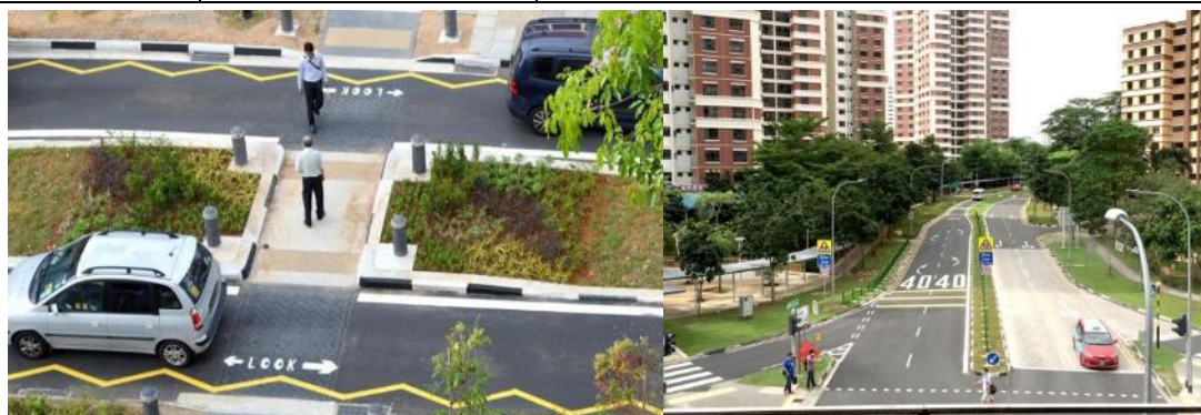
圖 15 新加坡銀髮安全區規劃之路口穿越設計 資料來源：新加坡陸路交通局，2014
