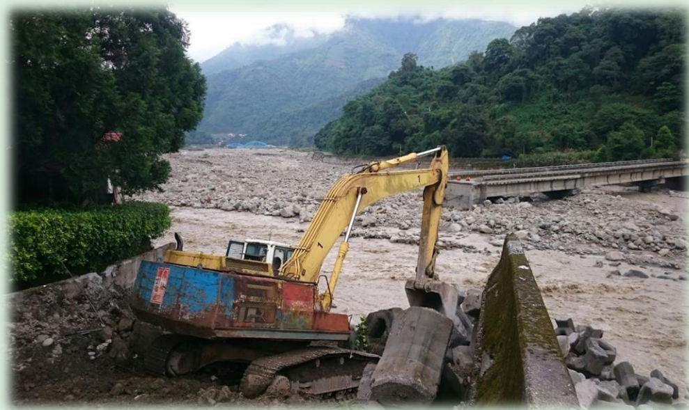
106年0601豪雨南投縣信義鄉同富村隆華部落 和社溪隆華橋搶險工程
