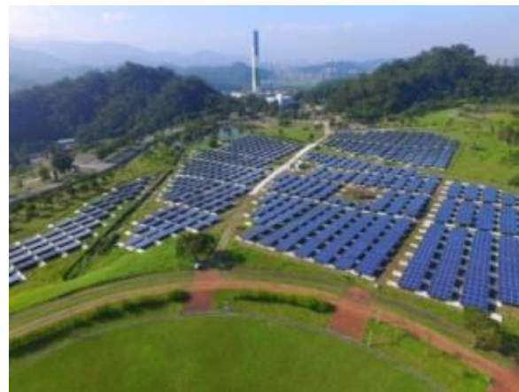
台北木柵 (2 MW) 垃圾掩埋場
