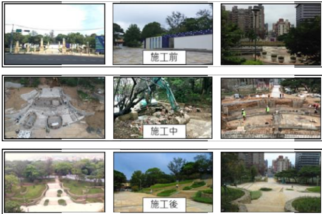
圖11 新竹公園百年大道環境再造工程改善照片
