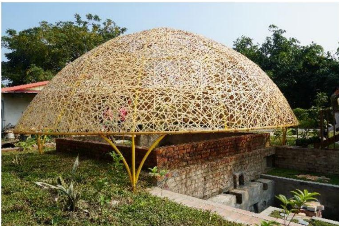
圖13 蕭家露天菸樓展示館
