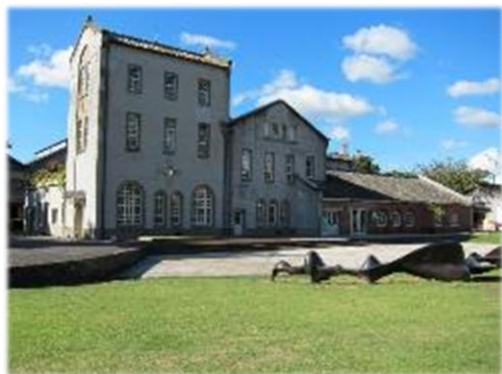
101年完成華山園區整建工程
