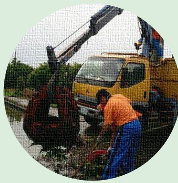
災害復原排水路
