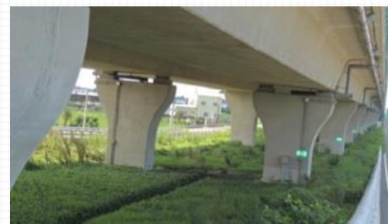
彰化福興及漢寶交流道等路段 設置排水管導流至橋下空地及生態溝，避免影響當地水文系統。
