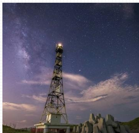
七股 國聖燈塔 - 臺灣本島極西燈塔
