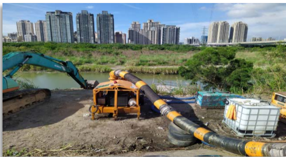
新竹隆恩堰下游水坑抽水
