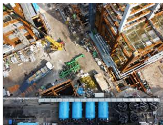
建築工地地下水利用 (快濾桶及管線)
