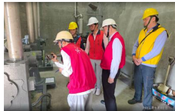
抽檢縣市水門、抽水站
