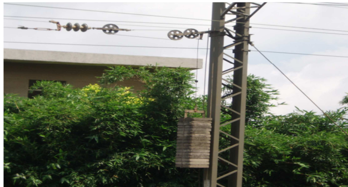
圖 1.32 傳統式自動平衡錘
