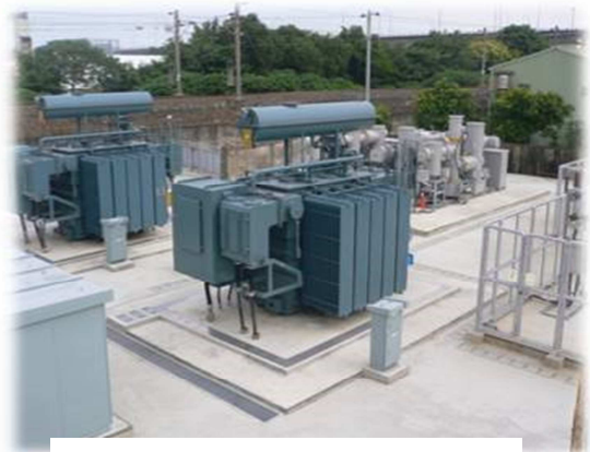
圖 1.36 25MVA 變壓器
