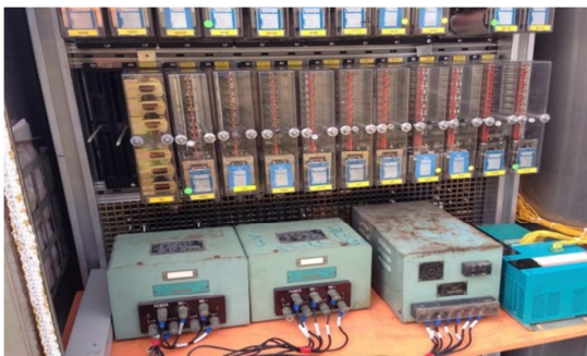
圖 4.8 平交道繼電式控制組
