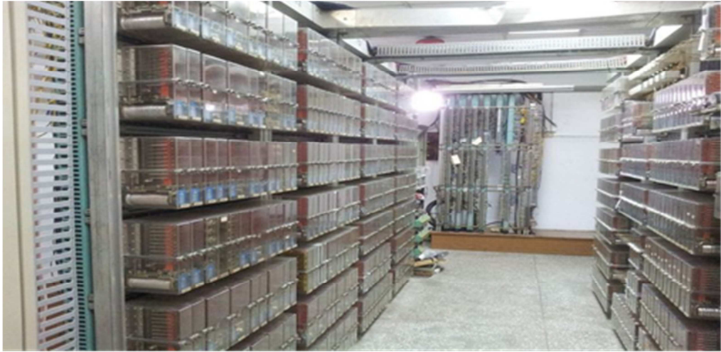
圖 1.9 繼電聯鎖(繼電器架)
