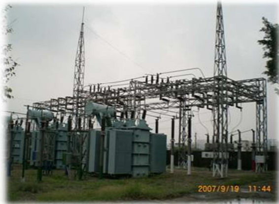
圖 1.35 10MVA 變壓器
