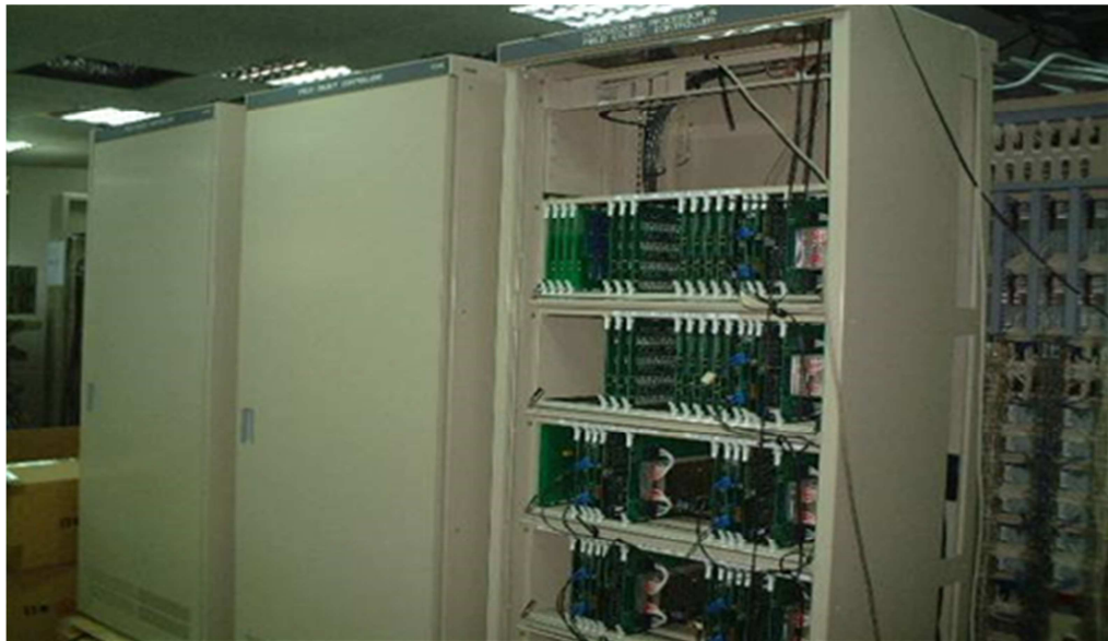
圖 1.9 繼電聯鎖(繼電器架)
