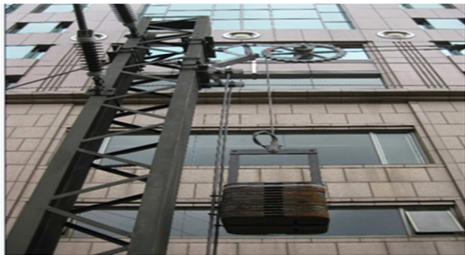
圖 4.21 自動平衡錘裝置
