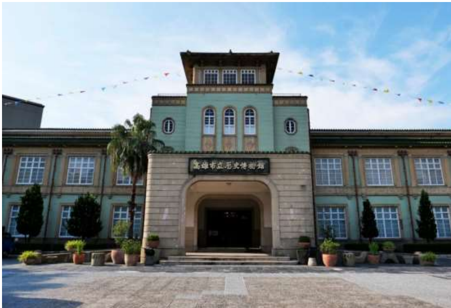
說明：原高雄市政府現況。（照片提供：翁睿宏）
