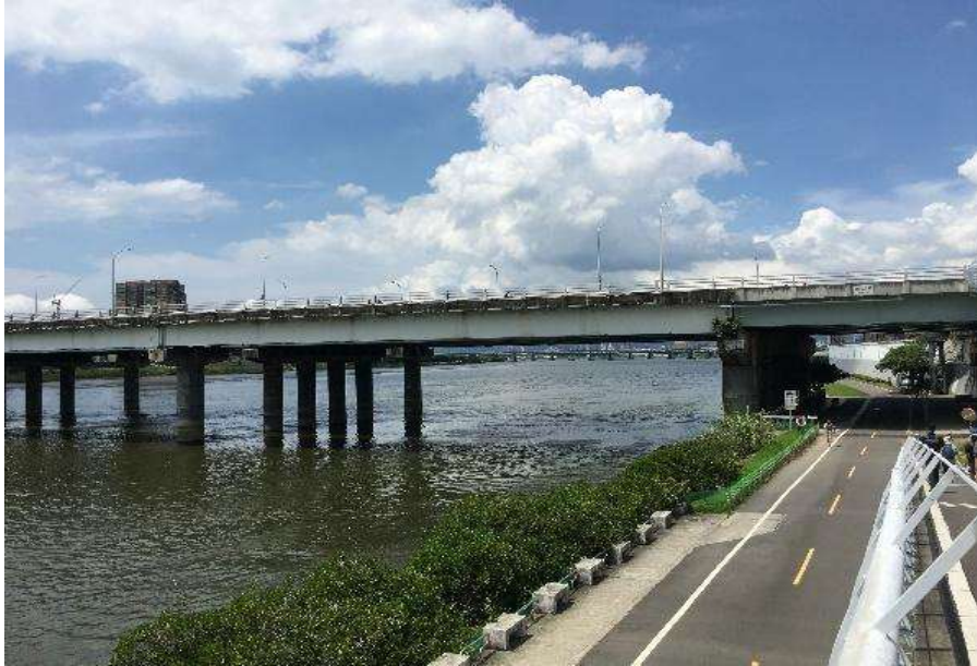
說明：臺北橋現況。(照片提供：國立臺北藝術大學建築與文化資產研究所)
