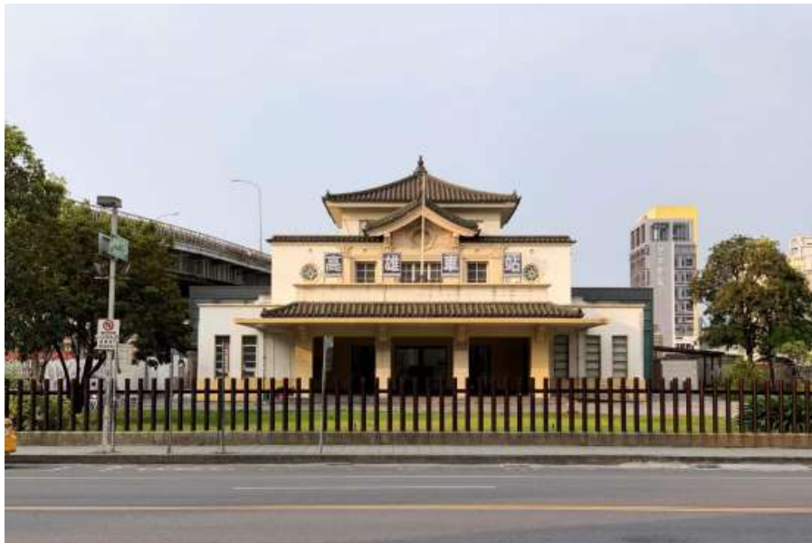
說明：原高雄車站現況（照片提供：翁睿宏）
