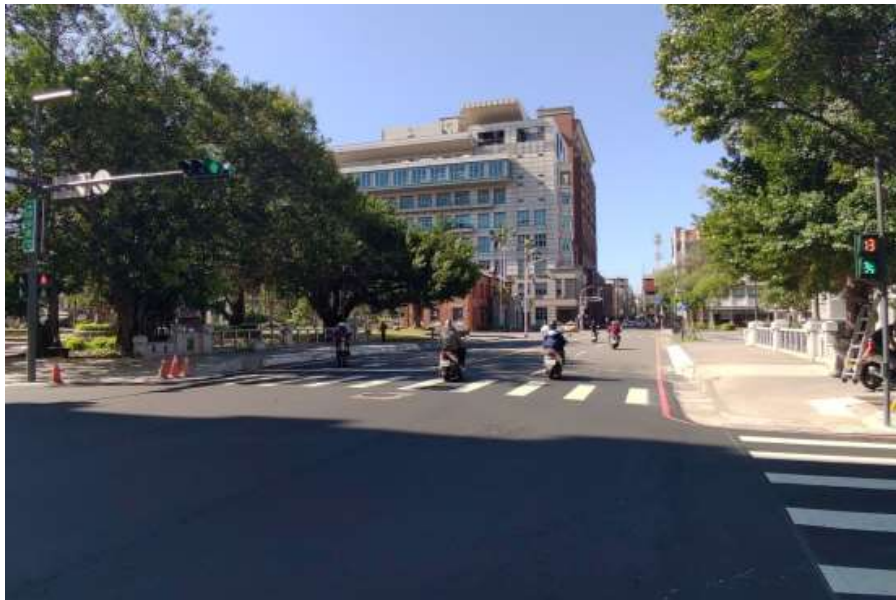
說明：新竹原旭橋現況。(照片提供：草根意識工作室)
