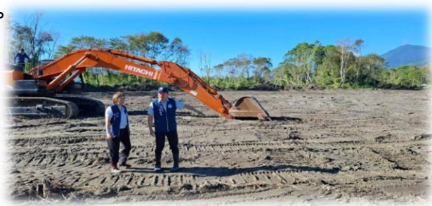
淤泥暫置場整地中
