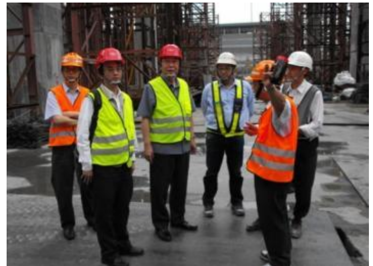
建築工程施工現況
