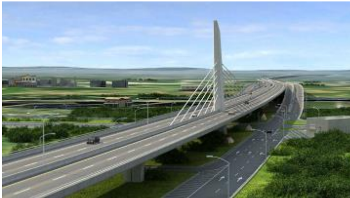
永安漁港斜塔脊背橋
