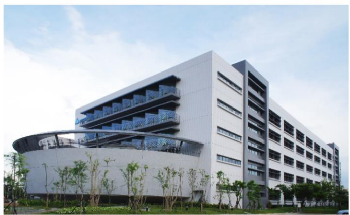
台達電子 南科廠二期廠房
