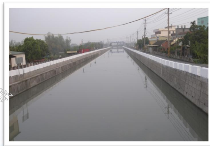
石筍排水改善工程
