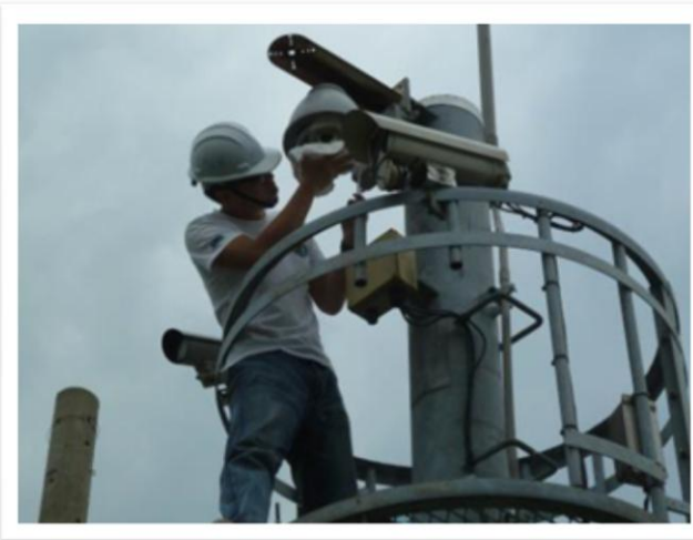
CCTV監視站檢測
