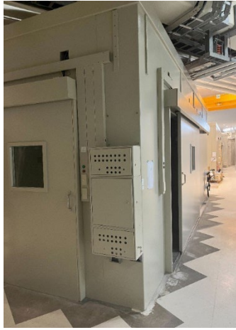
輻射屏蔽屋建造完成圖
