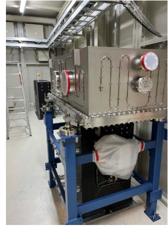
聚焦鏡箱安裝現場
