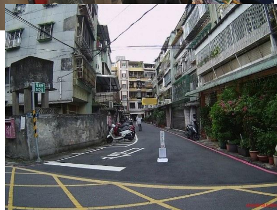
↑ 永和區永福段 587 地號土地 ↑ 永和區永福段 685 地號土地 (即豫溪街 217 巷)。 行政執行小知識 (即豫溪街 162 巷)。
