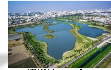
滯洪池179座 (滯洪量4,006m 3 )
