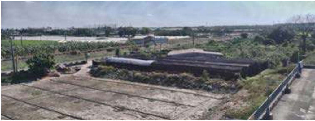
圖 4.3.1-2 站址方案 A 既有渠道現況照片
