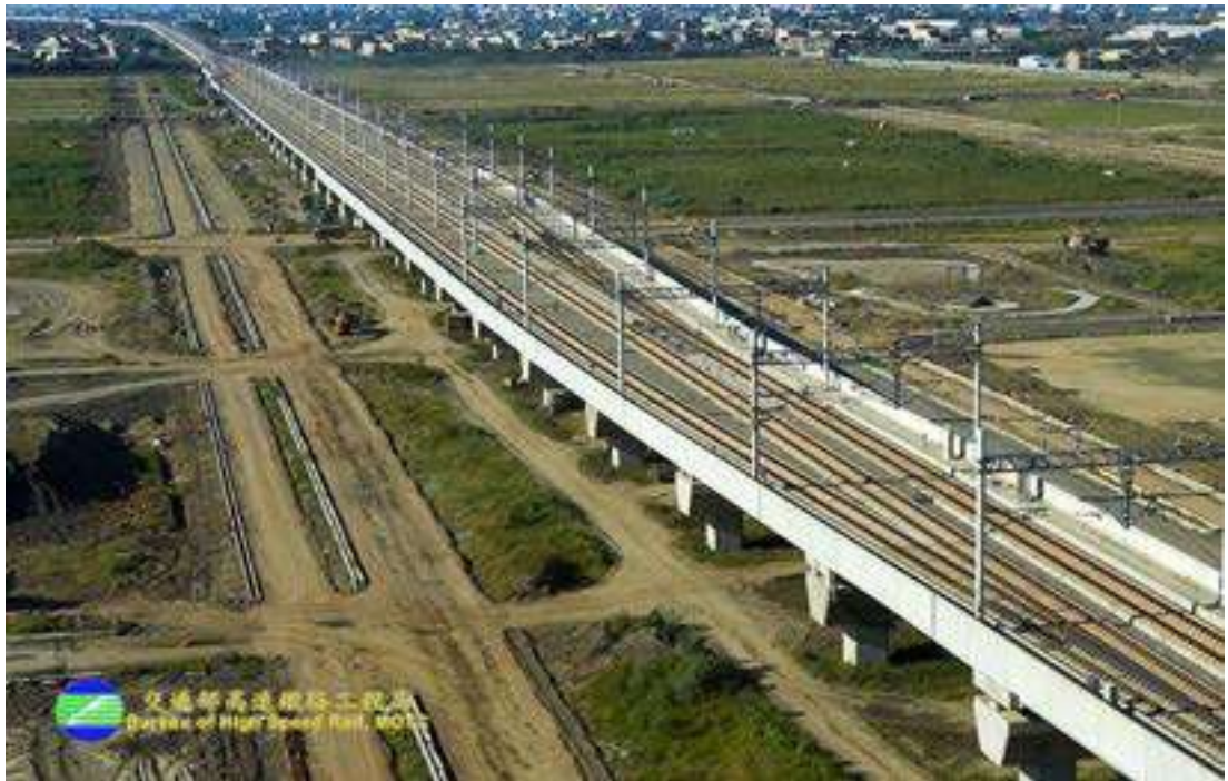
圖 5.8-2 雲林站正線與副正線完成照片
