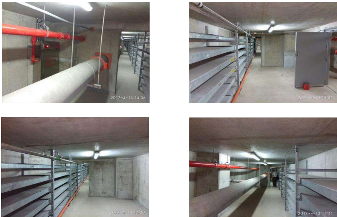
圖 15.4.1-10 高鐵月台下方既有機電管線現場勘查照片
