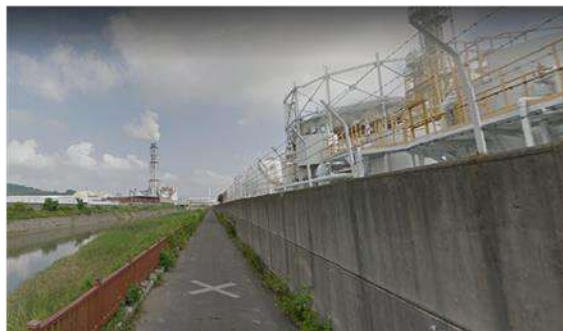
圖 5.7-4 仁武工業區石化工廠衛星影像截圖及相片
