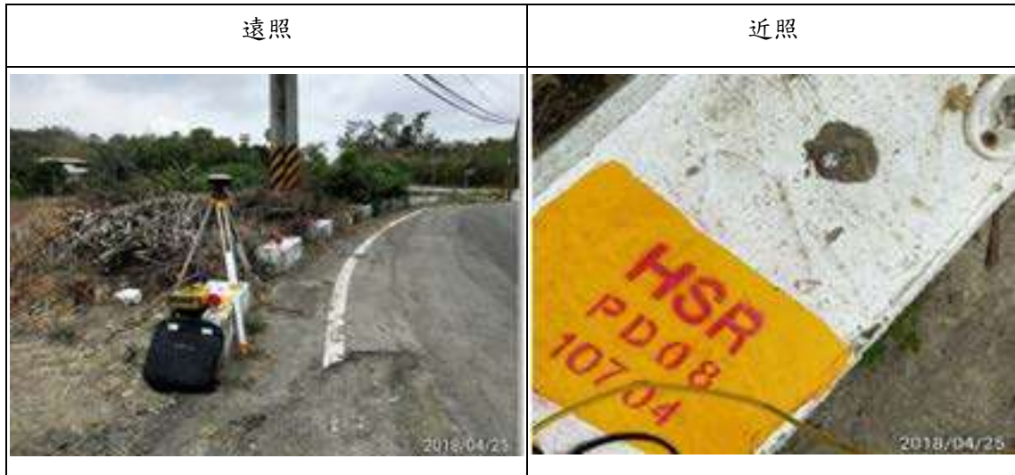
圖 5.10.3-2 鋼樁現場佈設
