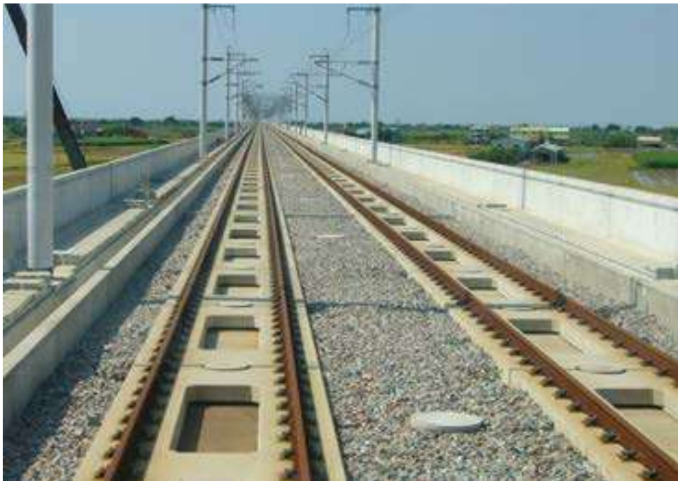
圖 5.3.1-2 日本版式軌道(J-Slab) 框形軌道版
