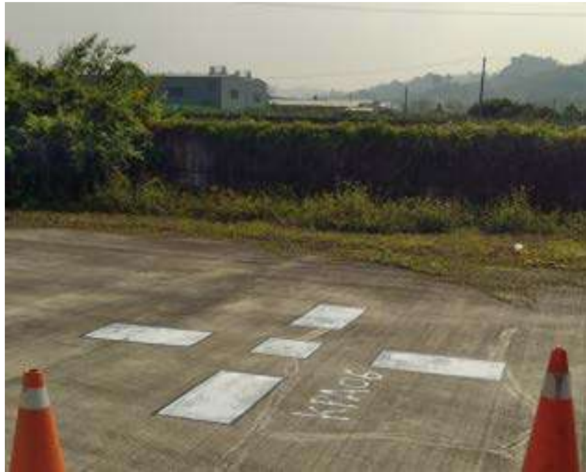
圖 5.10.3-4 航空標現場佈設
