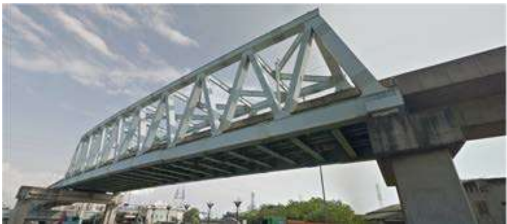
圖 5.2.2-2 高鐵鋼桁架簡支梁橋
