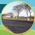
南星路以轉爐石瀝青 路面改善後照片
