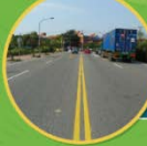
新生橋至安瀾路道路拓寬工程 以底渣作為瀝青底層改善後照片
