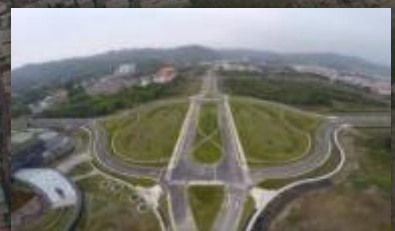
南核心開發公共設施(已完工)
