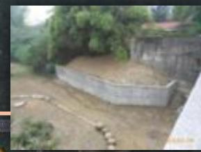
金城一橋護坡及排水改善工程(已完工)
