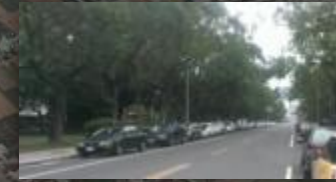
光明路公共工程改善工程(已完工)
