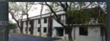
松園56館建物改善(已完工)
