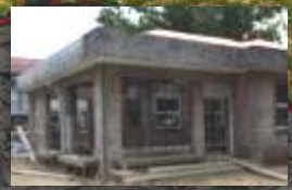
未來屋(施工中)
