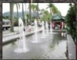
省府路景觀改善工程(已完工)
