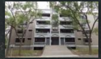
金城社區建物改善(已完工)
