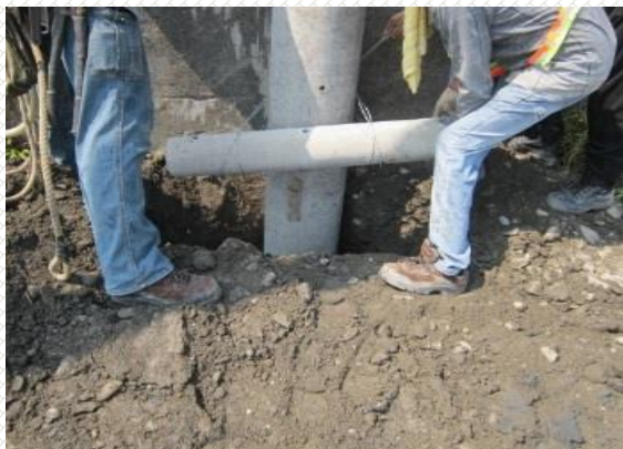
桿基改善 (加裝水泥腳木)
