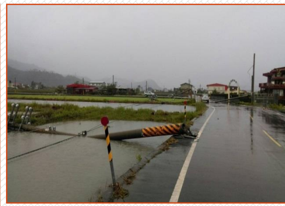
根部破壞(根部折斷)
