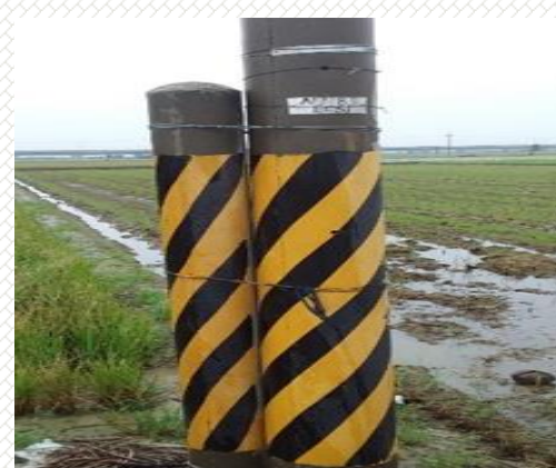
桿基改善(加裝基樁)
