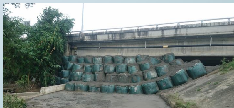
水利署第五河川局於8月25日立即以防 汛塊及太空包搶險，已完成3道防線。
