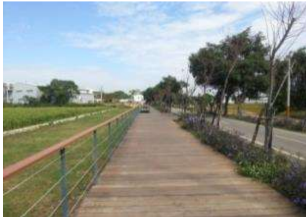
中區 臺中潭雅神自行車綠廊
