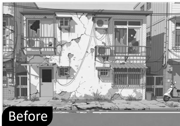
外牆磁磚掉落影響公安
