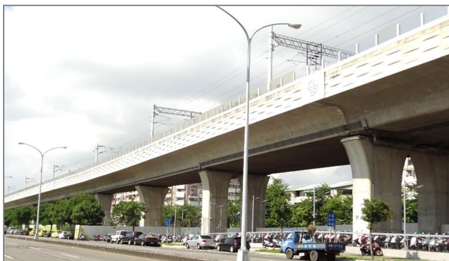
圖 5.1-1 橋寬漸變段預力箱型梁橋示意圖
