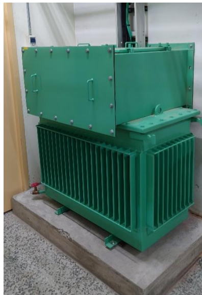
圖 4：112 年新建置之非晶質變壓器
