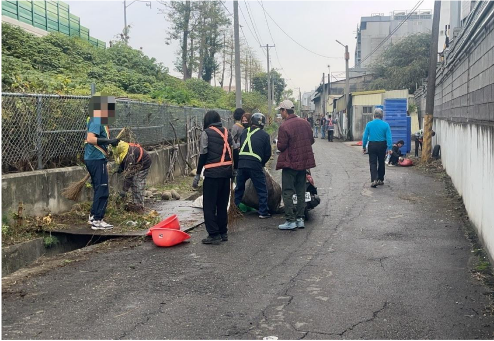
道路清掃現場照片
