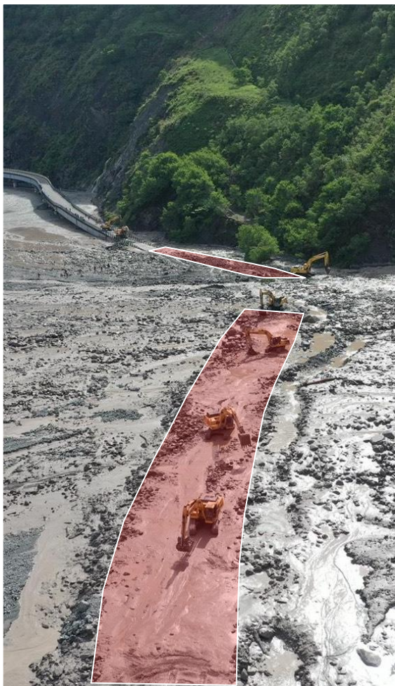
8月12日施工最後一哩路
