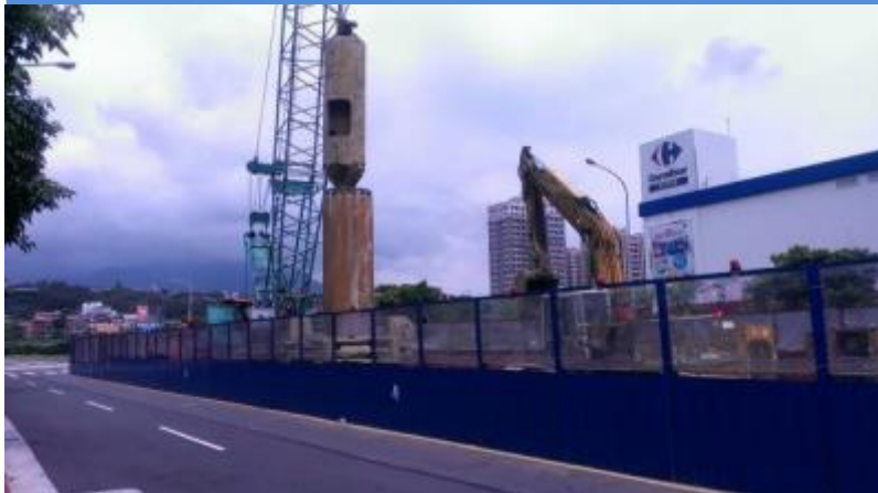
濱海路墩柱基樁施作
