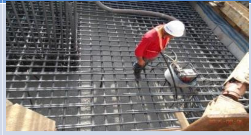
濱海路墩柱基礎版施作
