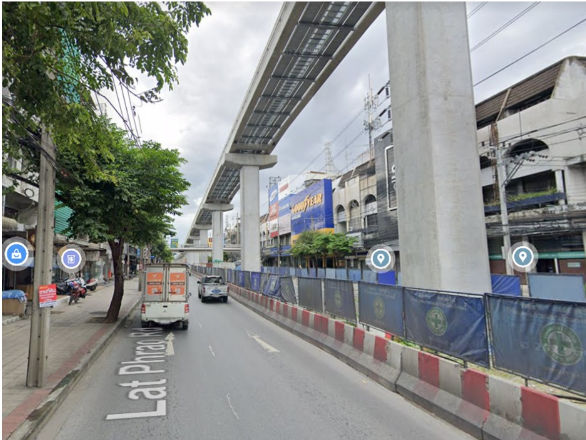
圖8-6 單軌高架橋檢修/逃生走道實例(泰國曼谷)
