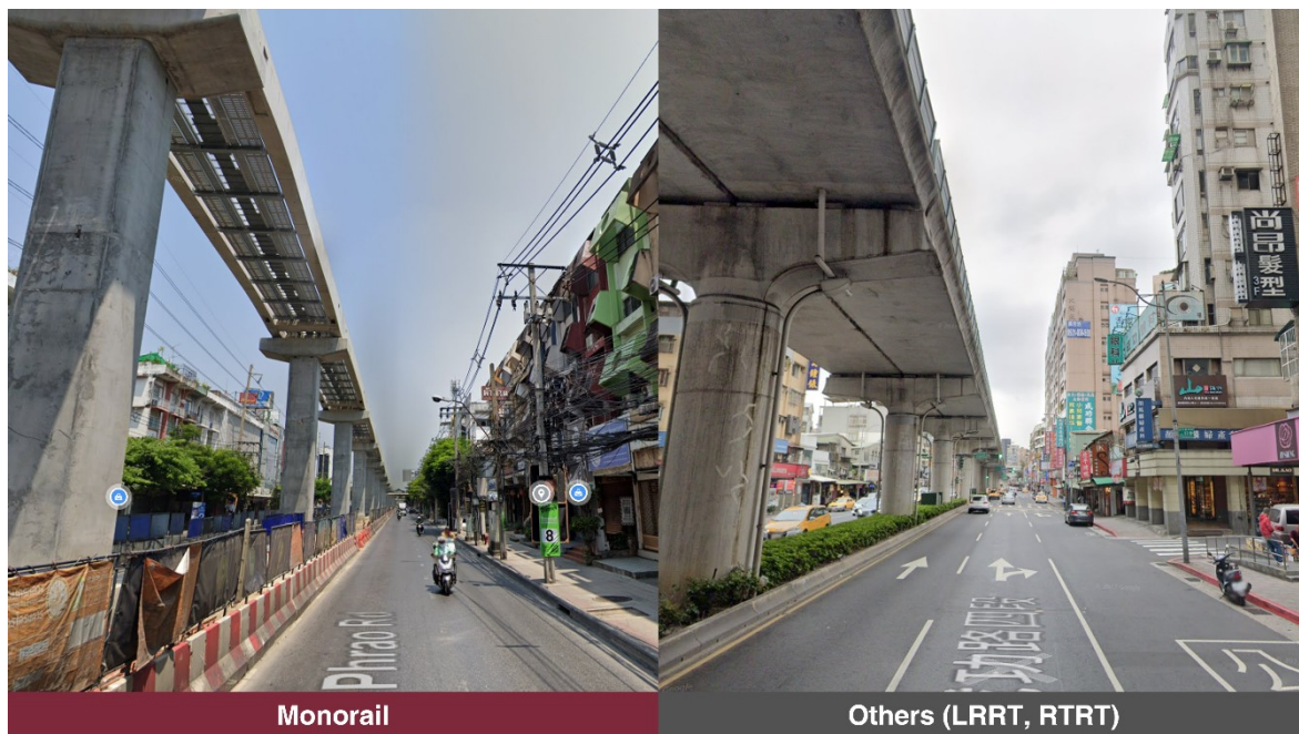
圖8-3 單軌捷運系統與傳統中運量捷運系統橋樑量體對照實景
