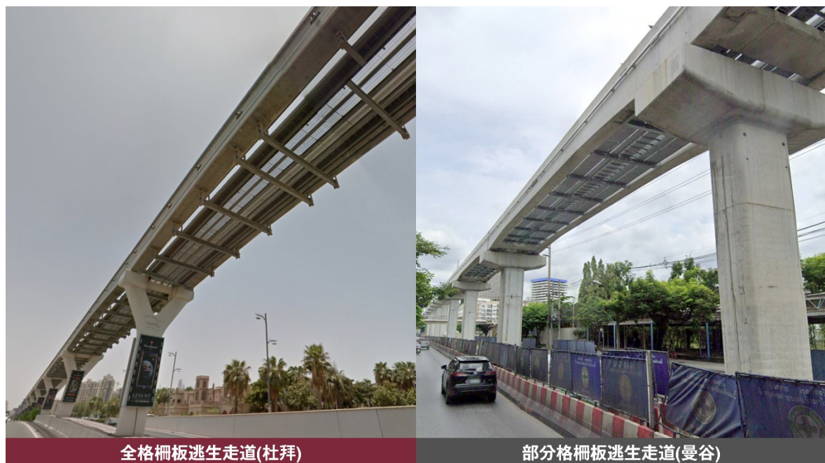
圖8-23 國外近年通車之單軌捷運系統檢修/逃生走道實景
