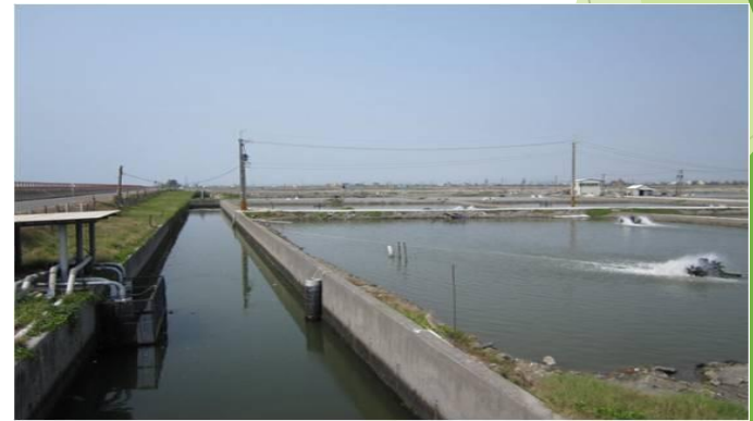
彌陀海水引水設施(明渠)(101.06.30)
