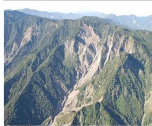
崩塌地現況照片(100年)
